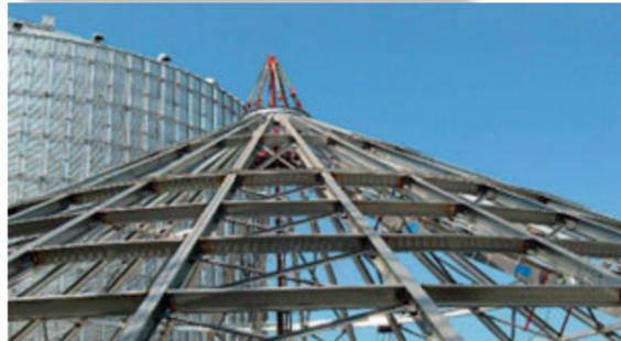
Mit seiner 30° Neigung, nimmt unser neues Dach hohe Lasten auf und ist dafür ausgelegt, die zusätzlichen Lasten aus TKF, Temperaturmessgehängen und erhöhten Schneelasten -abhängig von dem Aufstellort- zuverkräften. Seine Standardkonstruktion entspricht auch den gültigen Explosionsschutzvorschriften.
