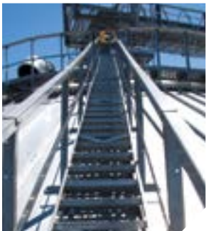
Plataforma de acceso para la sección intermedia del techo
