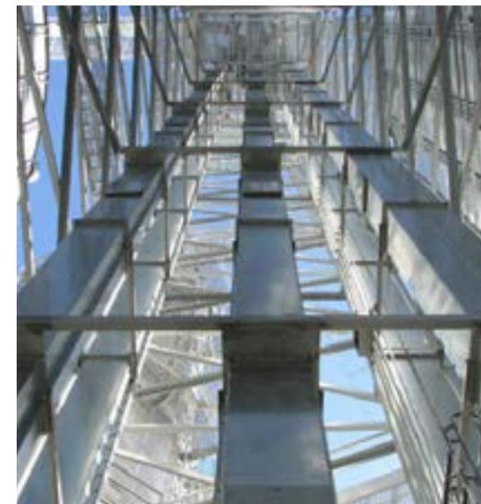
Para una óptima vida útil, Chief ofrece sistemas totalmente galvanizados de transporte de materiales para soportar las condiciones más corrosivas. Todos los componentes tienen construcción robusta y están diseñados para tener un fácil mantenimiento.
